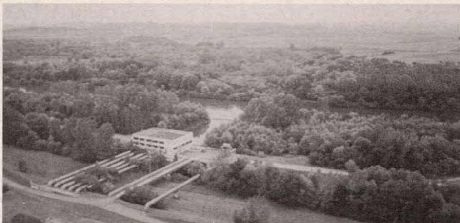
Vorher – Blick vom Kraftwerksturm Irsching zur Kühlwasserentnahme
