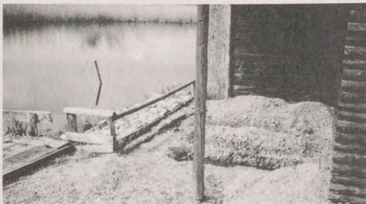
Die Betonierung der Terrasse ist bereits abgeschlossen
