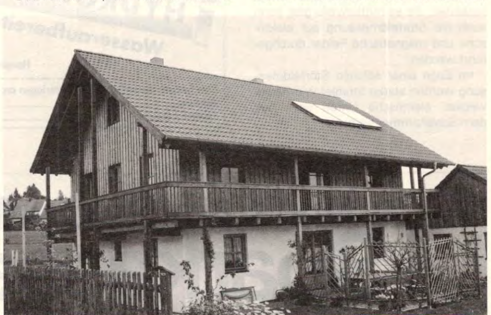
Niedrigenergiehaus in Raffenstetten bei Schweitenkirchen
