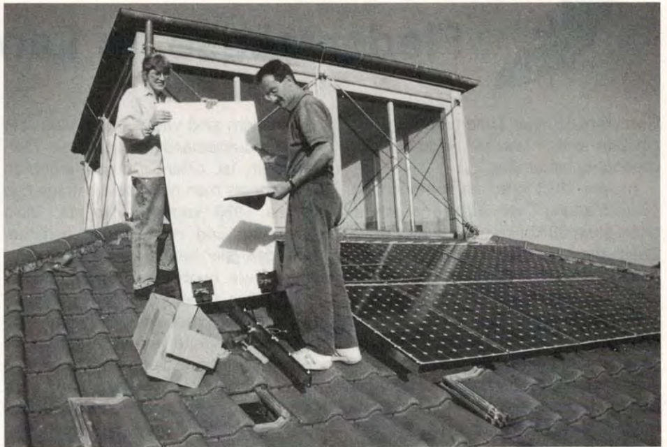
Neben dem eifrigen Einsatz von Theresia Regler und Sigi Ebner, die gerade die beiden letzten Module installieren, ist vor allem die gelungene architektonische Eingliederung der Solarstromanlage in das Gebäude hervorzuheben.
