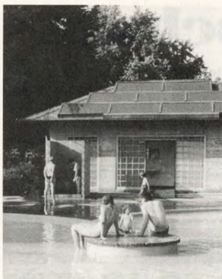
BN spendet im Schwimmbad Pfaffenhofen eine Solar-Warmwasseranlage (1995)
