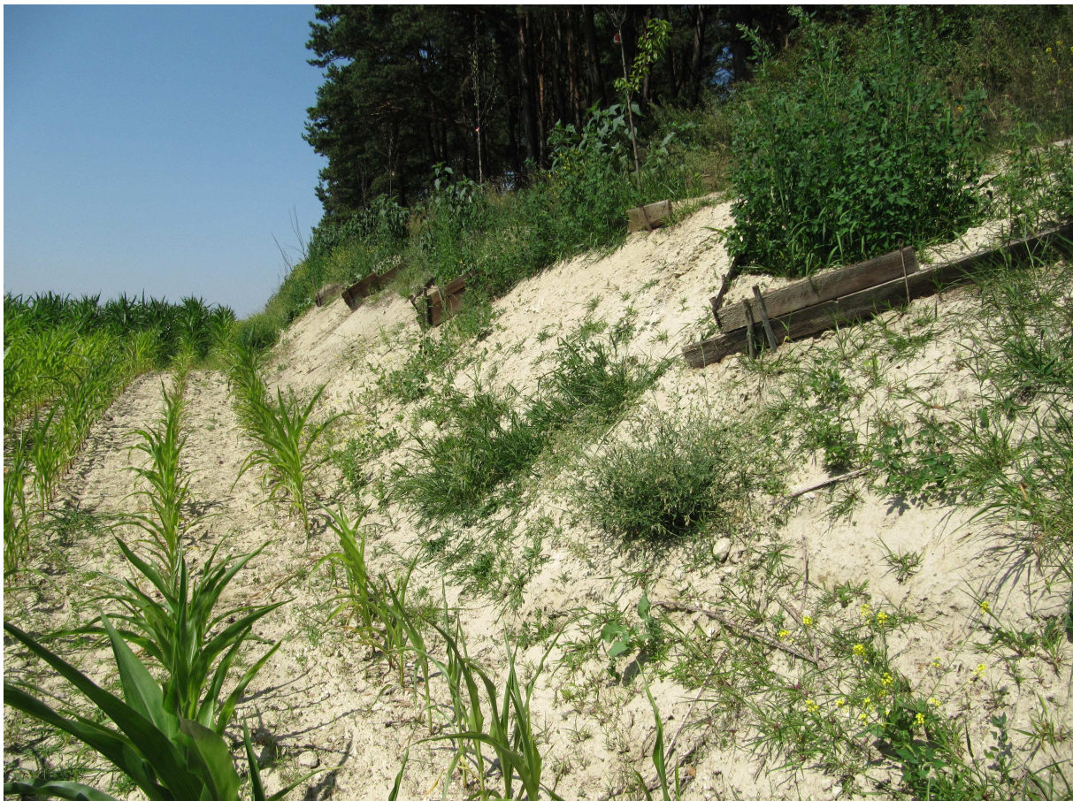
Abb. 13: Durch den Landwirt sanierte Abbruchkante am ursprünglichen Nistplatz
